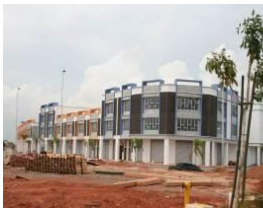
Gambar 4.13 Bangunan Kedai Kos Rendah 3 Tingkat
