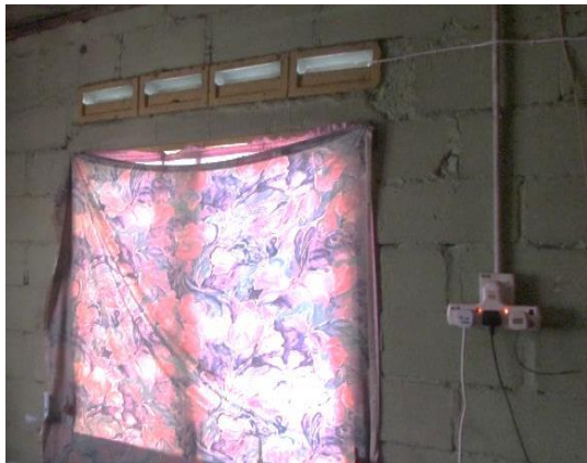
Gambar 2.12 Dinding Dalam Tidak Diplaster
