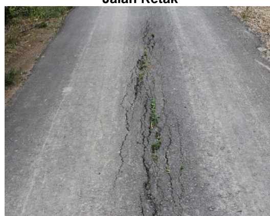
Gambar 1.4 Jalan Retak
