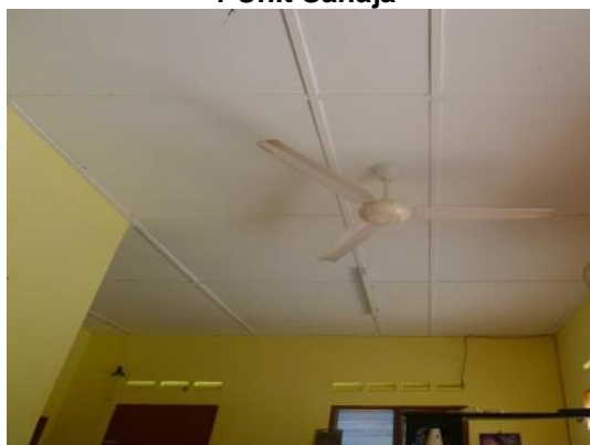
Gambar 2.3 Kerja Pendawaian Elektrik Kipas 1 Unit Sahaja
