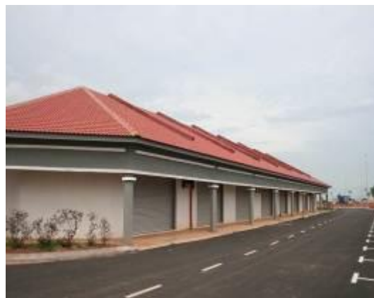
Gambar 4.12 Bangunan Kedai Kos Rendah Satu Tingkat
