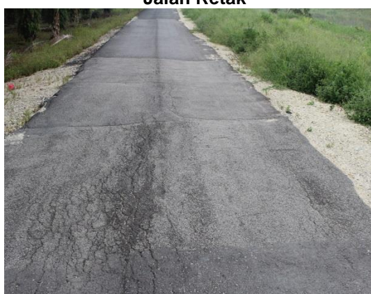
Gambar 1.3 Jalan Retak
