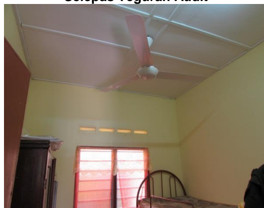
Gambar 2.4 Pemasangan Kipas Di Bilik Tidur Selepas Teguran Audit
