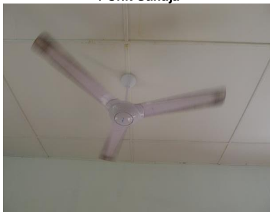
Gambar 2.1 Kerja Pendawaian Elektrik Kipas 1 Unit Sahaja
