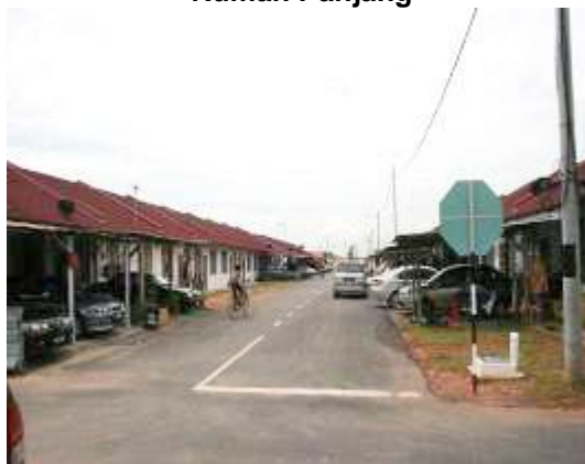
Gambar 4.11 Sebahagian Daripada 150 Unit Rumah Panjang
