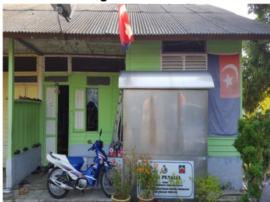
Gambar 2.29 Kiosk Tidak Digunakan Kerana Kawasan Perniagaan Tidak Sesuai
