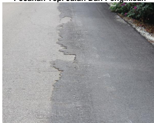
Gambar 1.8 Pecahan Tepi Jalan Dan Pengikisan
