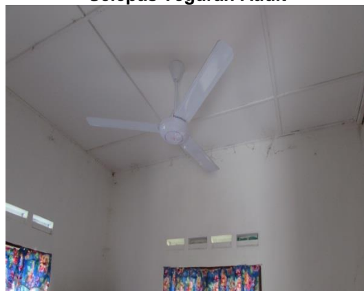
Gambar 2.2 Pemasangan Kipas Di Bilik Tidur Selepas Teguran Audit
